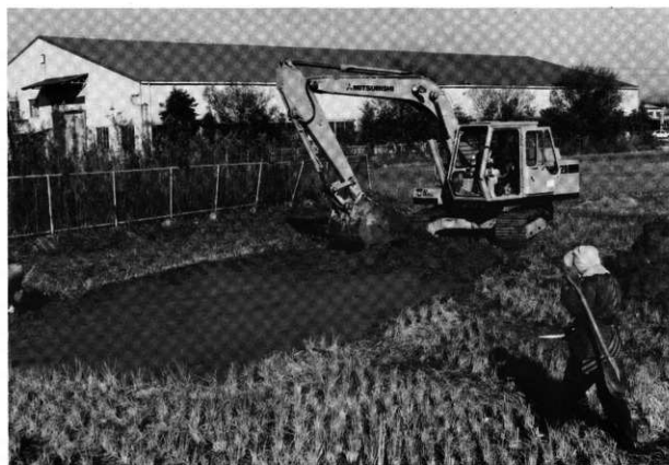
2. 表土除去作業
