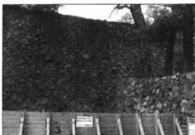
⑦二之丸高石垣：石垣現状が滑動を起こし、加えて上部石積が孕み出しの変形を起こしている。
