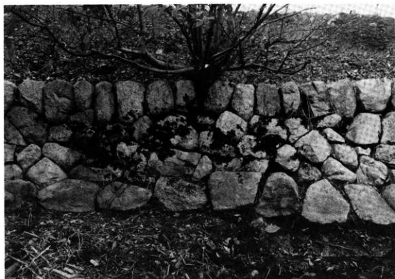
石積み の状況
