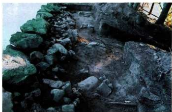
T-2天端部分完掘状況
