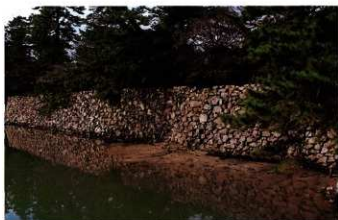
二之丸下ノ段東側堀石垣
