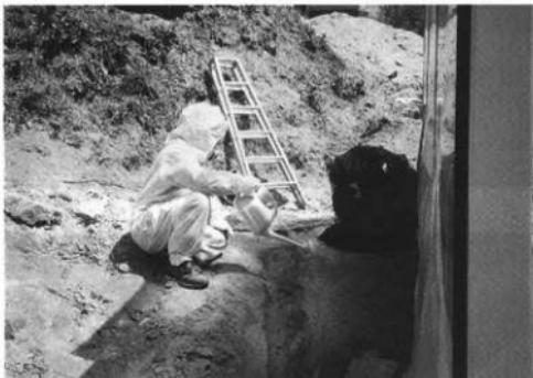
表層よりはジョロにより含浸を行った。連続含浸を行わず一定の硬化養生期間を設けた後、さらに含浸させて出来るだけ防水幕を形成するように含浸強化した。
