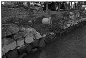
石垣の解体工事
