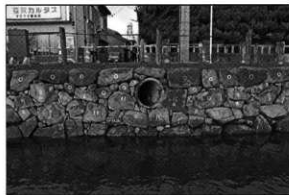
修理完了状況
