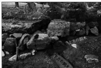
春風埦東側の護岸（詳細） 下方の胴木の上に粘土層があり、その粘土層の上に胴木が設置されている。江戸時代に護岸の改修がなされて、胴木の再設置が行われたようである。
