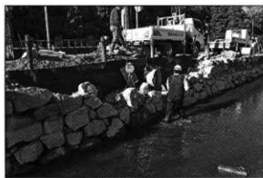
石垣の積み直し工事
