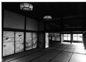
解体修理前の御書院内部（御次之間より）
