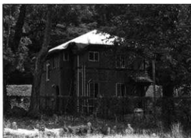
保存修理前の北館
