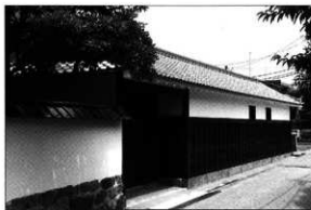
旧池田屋敷長屋門外観（修理後）
