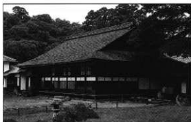
解体修理前の御書院外観（北東側）
