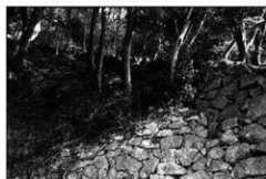
西の丸三重櫓の高石垣の西端に取り付く登り石垣
