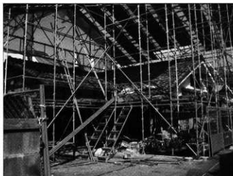
修理中の足軽屋敷 (旧磯島家住宅)
