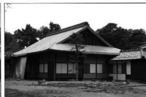
解体修理後の御書院外観（南西側）
