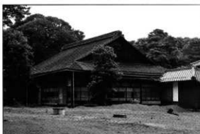
解体修理前の御書院外観（南西側）
