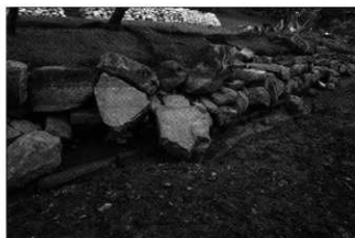
春風埦東側の護岸 江戸時代に改修された石積み護岸。胴木がずれないように杭が裏所に打たれている。
