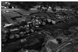
春風埦東側の護岸 池に張り出した大きな石組みなどは、石組みの下に直接胴木を据えている。
