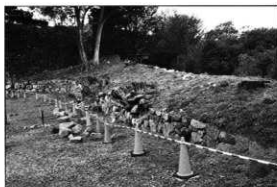
調査前の太鼓丸東側の石壁石垣の全容
