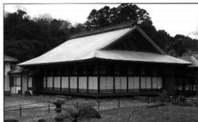
解体修理後の御書院外観（北東側）
