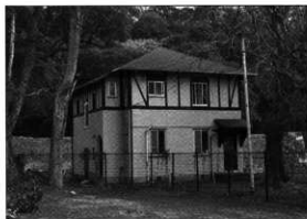
保存修理後の北館
