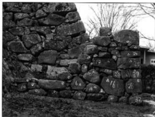
太鼓櫓下の石垣保存修理状況(側面より)
