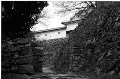
井戸曲輪の石垣保存修理完了状況
