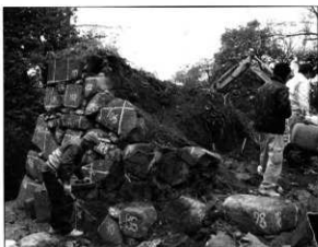
井戸曲輪の石垣保存修理状況
