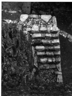
太鼓櫓下の石垣保存修理状況(太鼓櫓より)
