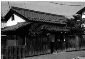
足軽屋敷(林家住宅)外観
