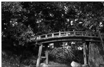
飛梁溪橋の現状
