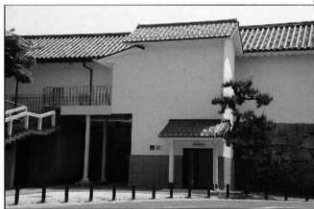
エレベーター本設置完了状況
