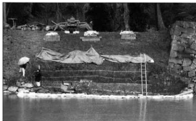
大手門西側の石垣調査風景
