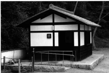
黒門番所を外観復元した公衆便所
