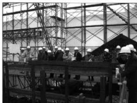
復元工事の説明を聞く見学者
