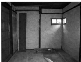
辻番所室内(工事中)
