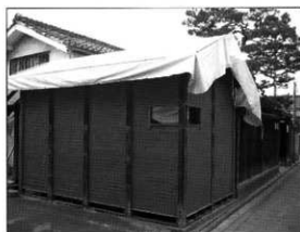
辻番所完壁工事
