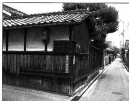
辻を覗むように設けられた辻番所（修理前）
