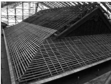
御書院の屋根工事
