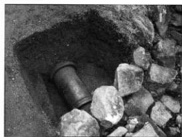
魚躍沼露岸側の陶製排水管
