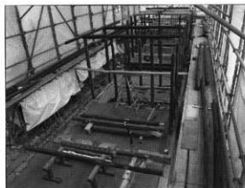
旧池田屋敷長屋門の軸組みの組み立て
