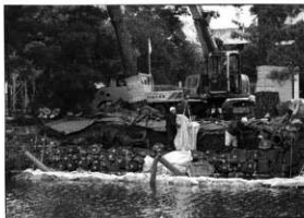
石垣の積み直し
