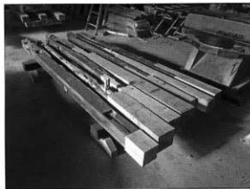
旧池田屋敷長屋門の部材の根継ぎ
