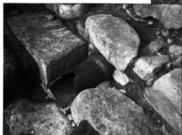
水門外側の陶製排水管
