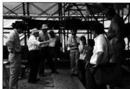
楽々園御書院棟解体修理工事の現地指導
