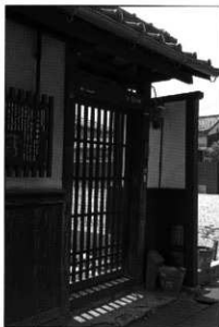
太田家住宅の保存修理箇所
