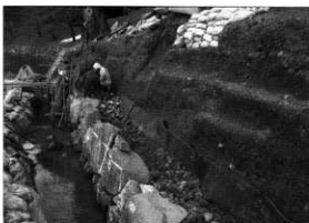
石垣の積み直し
