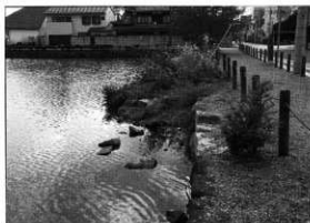
調査前の石垣の状況
