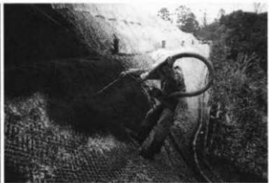
ジオファイバー工法（厚層基材吹付状況）
