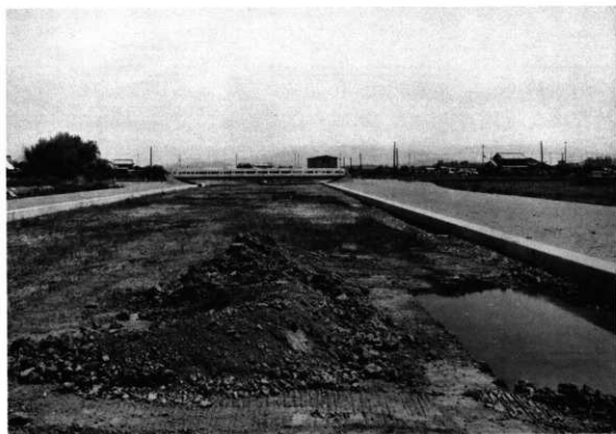
III区調査前全景 (下流より)
