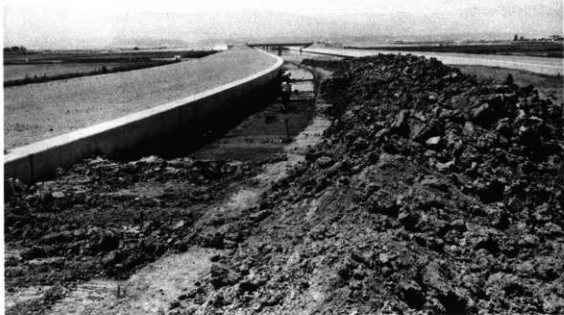
I区調査風景 (上流より)
