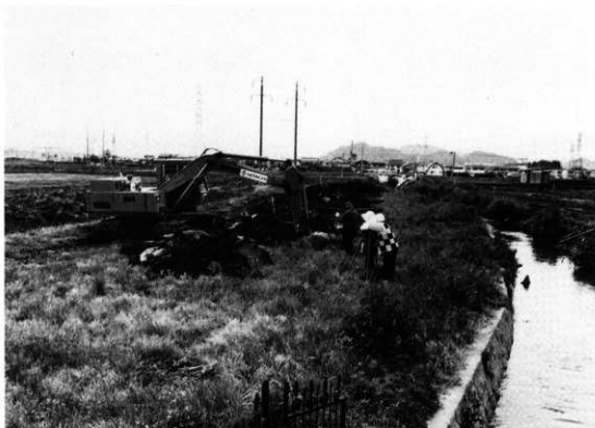
調査風景 (試掘トレンチ)
