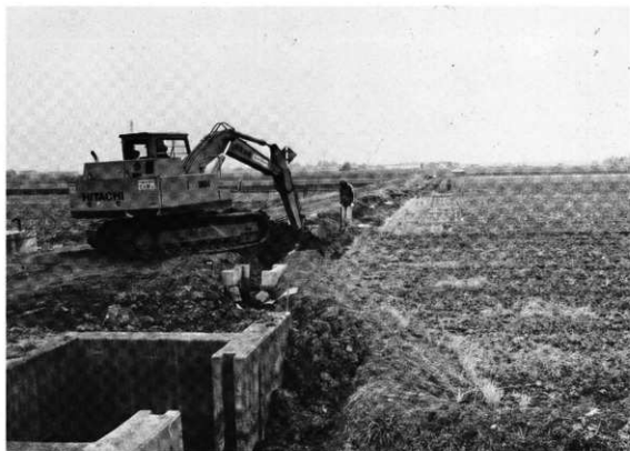
トレンチ1 遠景(南東より)
