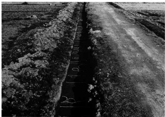
トレンチ3 全景（南西より）
