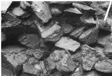
b区 堰堤状施設 大礫石積みみ状況 (東より)
