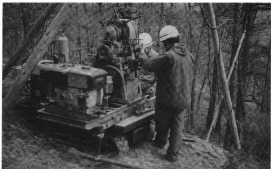
9. ボーリング作業風景
