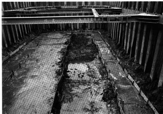
完掘後(東から)
