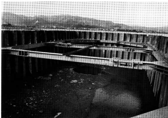
調査前近景(東から)
