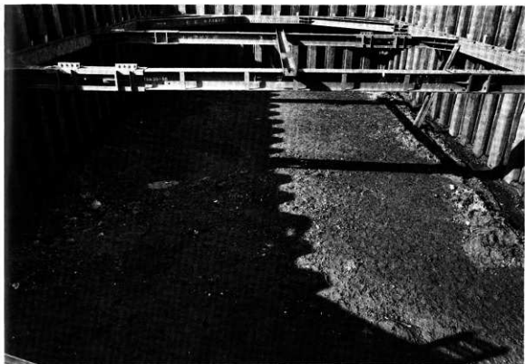
調査前近景(東から)
