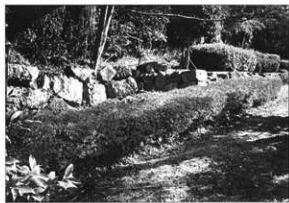
写真39 修理前（正面から撮影）
