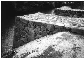
写真18 修理後 (米蔵水門石垣第3面)
