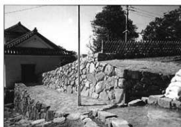
写真67 修理後（北から撮影）
