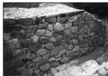
写真14 修理後(米蔵水門石垣第6面)
