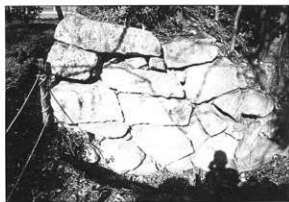
写真43 修理前（第2面南側）
