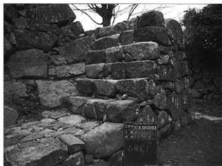
写真124 石垣No19修理完了状況
