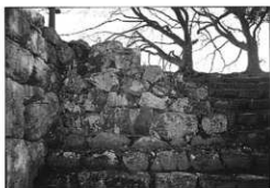
写真35 修理前（雁木石垣第5面）
