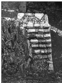
写真125 階段施設復元整備状況
