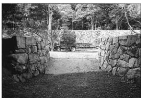
写真57 修理後（背面から撮影）
