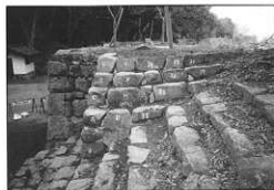
写真38 修理後（雁木石垣第6面）
