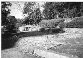
写真52 修理前（第3面、南から撮影）
