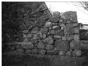
写真131 修理後 (石垣No19)
