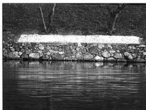
写真85 修理後（内堀沿い修理石垣No.10）
