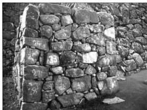
写真129 修理後 (石垣No18)
