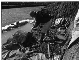
写真100 石垣解体状況1 (南から撮影)
