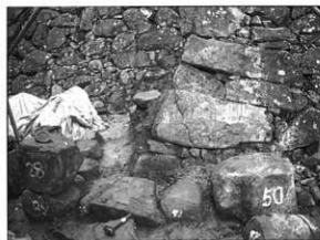
写真135 石垣No18解体完了状況
