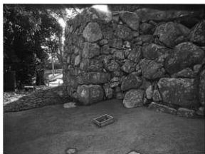
写真127 修理後 (石垣No18-1)
