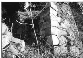
写真19 修理前 (米蔵水門石垣第1・5面)
