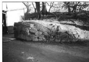
写真33 修理前 (御門石垣第3面)
