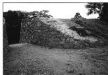
写真10 修理後(米蔵水門石垣第6面)
