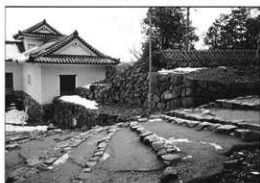
写真66 修理前（北から撮影）
