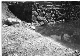
写真4 修理後（表御門橋石垣第1・2面）
