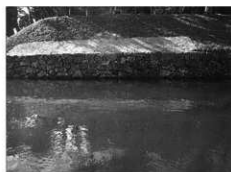
写真71 修理後(内堀沿い修理石垣No.3)
