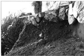
石垣No.9 南壁断面
