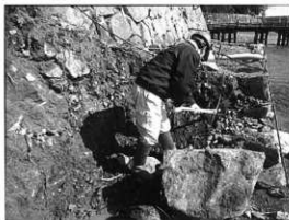
写真101 石垣解体状況2 (北から撮影)
