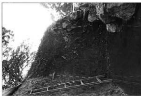
石垣No.7 南壁断面
