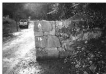
写真24 修理後(御門石垣第2面)
