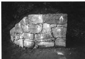
写真28 修理後 (御門石垣第1面)
