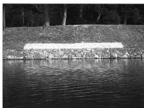
写真79 修理後（内堀沿い修理石垣No.7）
