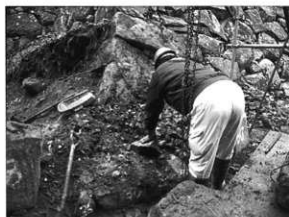
写真134 石垣No18解体状況
