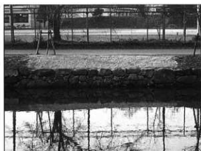
写真87 修理後（内堀沿い修理石垣No.11）
