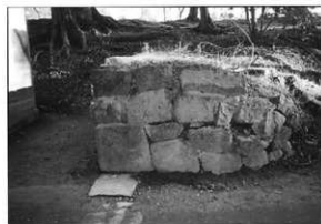
写真31 修理前 (御門石垣第3面)
