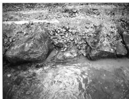
写真103 石垣底部確認状況2
