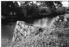
写真17 修理前 (米蔵水門石垣第3面)
