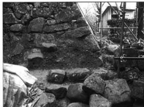
写真133 石垣No19解体完了状況
