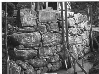
【下】写真59 石垣積直し状況（第4面）
