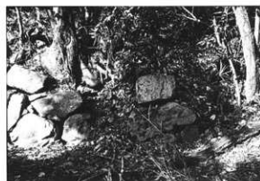
写真47 修理前（第2面北側）
