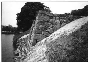
写真16 修理後 (米蔵水門石垣第3面)
