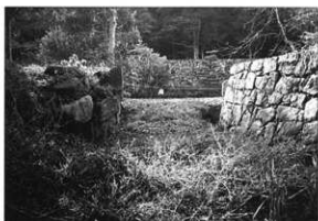
写真56 修理前（背面から撮影）
