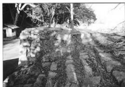
写真37 修理前（雁木石垣第6面）
