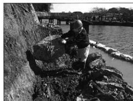
写真106 石垣積み直し状況 (北から撮影)
