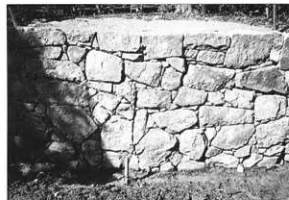
写真46 修理後（第2面中央付近）
