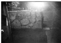
写真25 修理前(御門石垣第4面)
