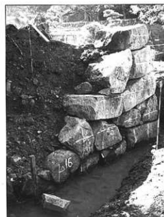
【左】写真60 石垣積直し状況（第4面）
