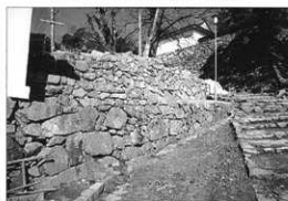
写真65 修理後（東から撮影）
