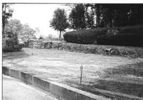
写真53 修理後（第3面、南から撮影）
