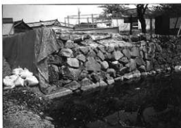
写真3 修理前（表御門橋石垣第2面）
