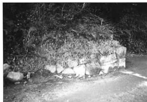
写真29 修理前 (御門石垣第1面)
