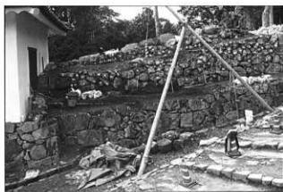
写真69 石垣修理状況
