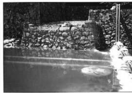
写真6 修理後（表御門橋石垣第4面）
