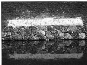
写真83 修理後（内堀沿い修理石垣No.9）
