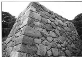
写真22 修理後 (米蔵水門石垣第2・6面)
