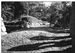
写真50 修理前（第3面、西から撮影）
