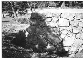
写真44 修理後（第2面南側）
