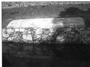
写真73 修理後（内堤沿い修理石垣No.4）
