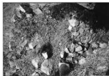
写真13 修理前(米蔵水門石垣第2・6面)
