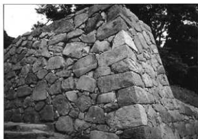
写真20 修理後 (米蔵水門石垣第1・5面)
