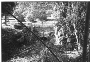
写真41 修理前（背面から撮影）
