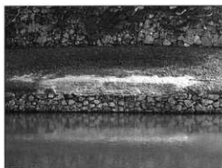
写真90 修理後 (内堀沿い修理石垣No.12)
