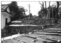
写真62 修理前（正面から撮影）
