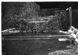
写真5 修理前（表御門橋石垣第4面）
