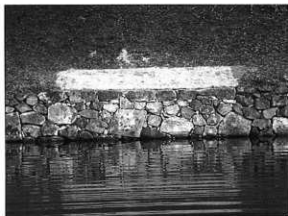
写真81 修理後（内堀沿い修理石垣No.8）
