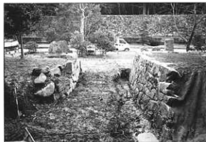
写真42 修理後（背面から撮影）
