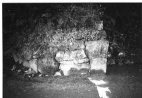
写真27 修理前 (御門石垣第1面)
