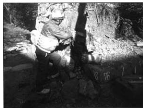
写真121 石垣117・118解体状況
