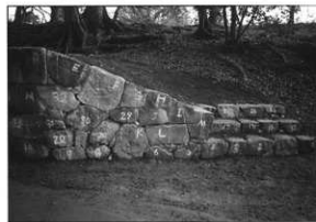
写真34 修理後 (御門石垣第3面)
