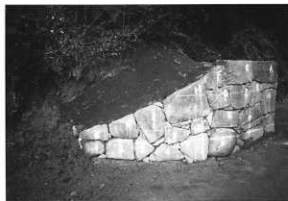
写真30 修理後 (御門石垣第1面)
