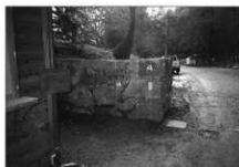
写真26 修理後(御門石垣第4面)
