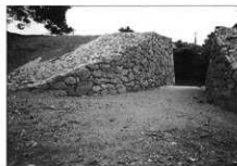
写真12 修理後(米蔵水門石垣第5面)
