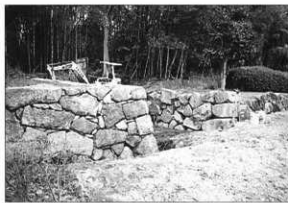
写真40 修理後（正面から撮影）
