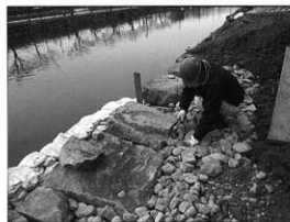
写真107 裏込栗石充填状況 (南から撮影)
