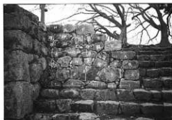
写真36 修理後（雁木石垣第5面）
