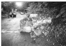
写真23 修理前(御門石垣第2面)
