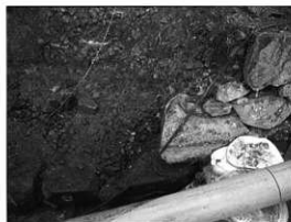
写真105 石垣底部確認状況4
