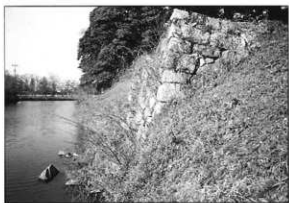
写真15 修理前 (米蔵水門石垣第3面)
