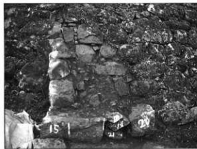
写真122 石垣102解体状況
