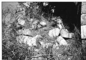
写真21 修理前 (米蔵水門石垣第2・6面)
