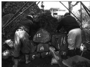
写真132 石垣No19解体状況
