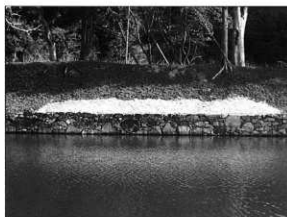
写真92 修理後 (内堀沿い修理石垣No.13)
