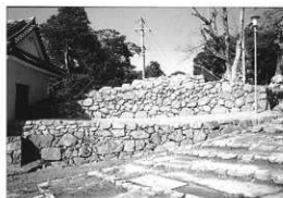
写真63 修理後（正面から撮影）
