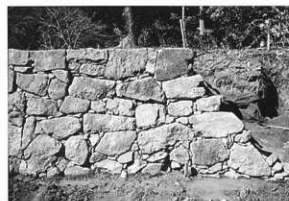
写真48 修理後（第2面北側）
