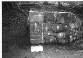
写真32 修理後 (御門石垣第3面)
