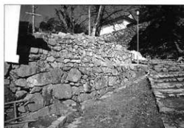
写真65 修理後（東から撮影）
