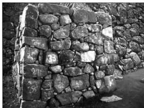
写真129 修理後 (石垣No18)
