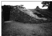
写真10 修理後(米蔵水門石垣第6面)
