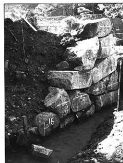
【左】写真60 石垣積直し状況（第4面）
