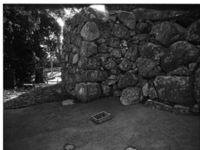
写真127 修理後 (石垣No18-1)
