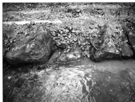
写真103 石垣底部確認状況2
