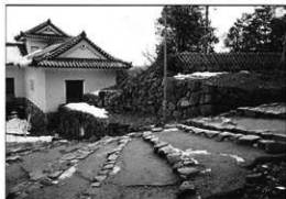
写真66 修理前（北から撮影）
