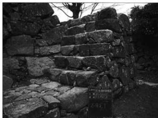
写真124 石垣No19修理完了状況
