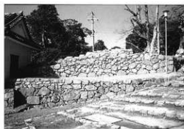
写真63 修理後（正面から撮影）
