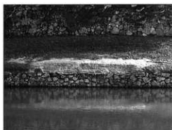
写真90 修理後 (内堀沿い修理石垣No.12)
