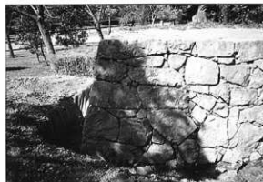
写真44 修理後 (第2面南侧)
