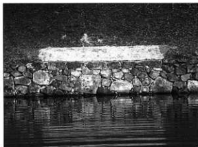
写真81 修理後（内堀沿い修理石垣No.8）
