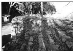
写真37 修理前（雁木石垣第6面）
