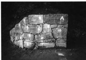
写真28 修理後 (御門石垣第1面)
