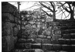
写真36 修理後（雁木石垣第5面）
