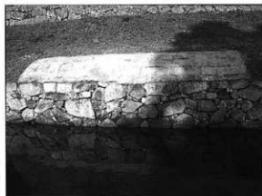
写真73 修理後（内堀沿い修理石垣No.4）
