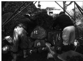
写真132 石垣No.19解体状況
