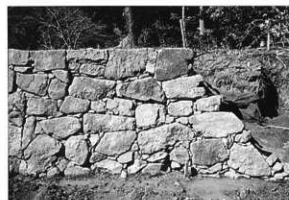
写真48 修理後 (第2面北側)
