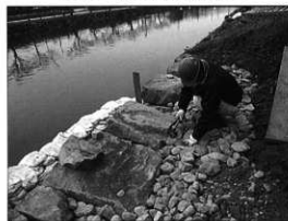
写真107 裏込栗石充填状況 (南から撮影)
