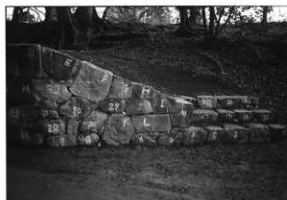
写真34 修理後 (御門石垣第3面)
