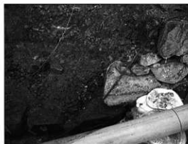
写真105 石垣底部確認状況4
