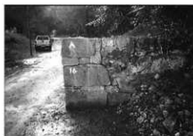
写真24 修理後(御門石垣第2面)
