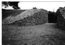
写真12 修理後(米蔵水門石垣第5面)
