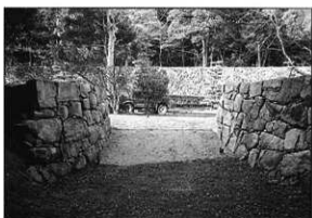
写真57 修理後 (背面から撮影)
