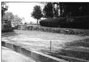
写真53 修理後 (第3面、南から撮影)
