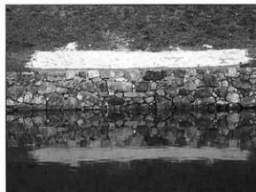
写真75 修理後（内堀沿い修理石垣No.5）
