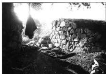
写真9 修理前(米蔵水門石垣第6面)
