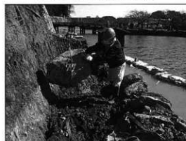
写真106 石垣積み直し状況 (北から撮影)
