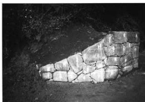
写真30 修理後 (御門石垣第1面)
