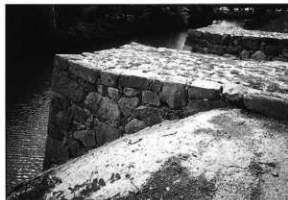
写真18 修理後 (米蔵水門石垣第3面)
