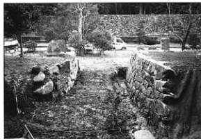
写真42 修理後 (背面から撮影)
