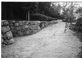
写真51 修理後 (第3面、西から撮影)
