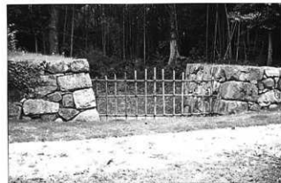
【下】写真61 石垣保存修理完了状況（正面から撮影）
