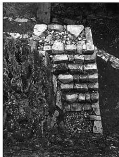
写真125 階段施設復元整備状況
