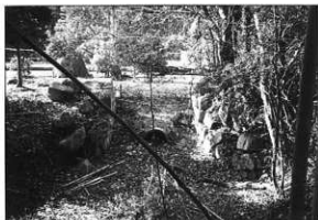
写真41 修理前 (背面から撮影)
