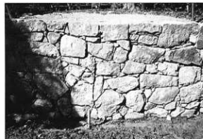
写真46 修理後 (第2面中央付近)
