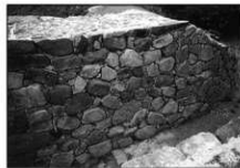
写真14 修理後(米蔵水門石垣第6面)
