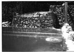
写真6 修理後（表御門橋石垣第4面）
