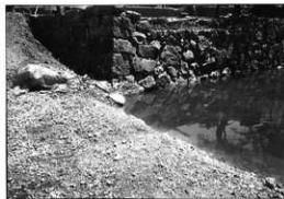
写真4 修理後（表御門橋石垣第1・2面）
