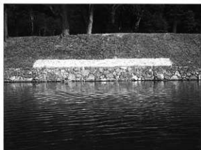
写真79 修理後（内堀沿い修理工石No.7）
