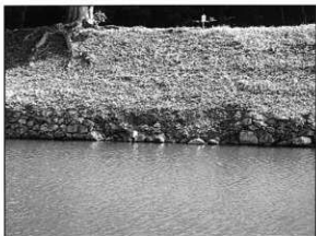
写真76 修理前（内堀沿い修理工石No.6）
