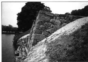
写真16 修理後 (米蔵水門石垣第3面)
