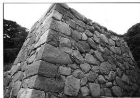
写真22 修理後 (米蔵水門石垣第2・6面)
