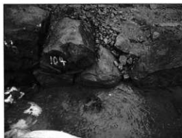
写真102 石垣底部確認状況1
