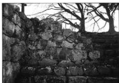
写真35 修理前（雁木石垣第5面）
