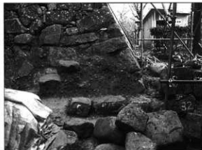
写真133 石垣No.19解体完了状況
