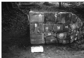
写真32 修理後 (御門石垣第3面)
