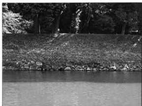
写真78 修理前（内堀沿い修理工石No.7）
