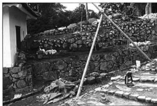
写真69 石垣修理状況
