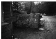
写真26 修理後(御門石垣第4面)
