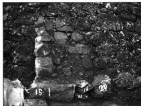
写真122 石垣102解体状況
