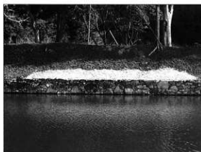
写真92 修理後 (内堀沿い修理石垣No.13)
