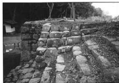
写真38 修理後（雁木石垣第6面）
