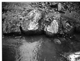
写真104 石垣底部確認状況3
