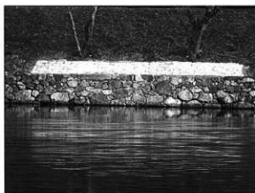
写真85 修理後（内堀沿い修理石垣No.10）
