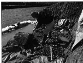
写真100 石垣解体状況1 (南から撮影)
