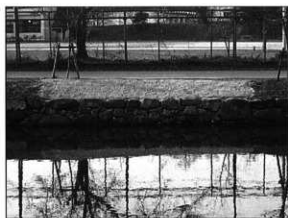
写真87 修理後（内堀沿い修理石垣No.11）
