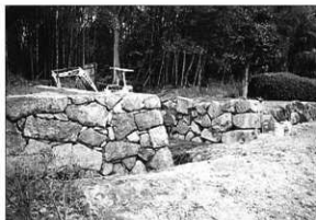
写真40 修理後（正面から撮影）
