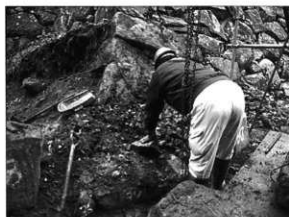
写真134 石垣No.18解体状況
