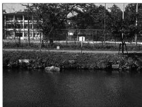
写真86 修理前（内堀沿い修理石垣No.11）
