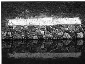
写真83 修理後（内堀沿い修理石垣No.9）
