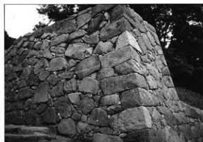
写真20 修理後 (米蔵水門石垣第1・5面)
