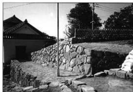
写真67 修理後（北から撮影）
