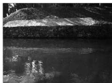
写真71 修理後（内堀沿い修理石垣No.3）
