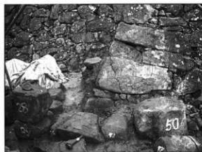
写真135 石垣No.18解体完了状況
