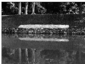
写真84 修理後 (内堀沿い修理石垣No.14)
