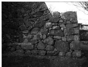
写真131 修理後 (石垣No19)
