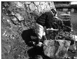
写真101 石垣解体状況2 (北から撮影)
