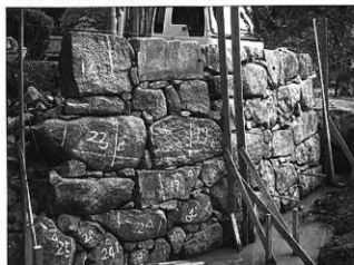
【下】写真59 石垣積直し状況（第4面）
