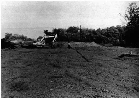
調査終了後埋めもどし作業
