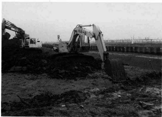
調査風景 (表土掘削)
