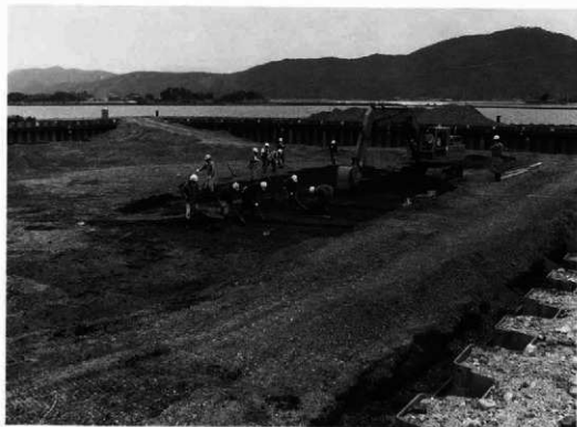
上層部掘削作業風景
