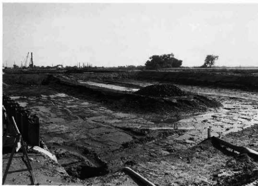
調査前状況（西南より）
