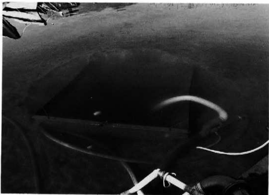
P-1 掘削状況
