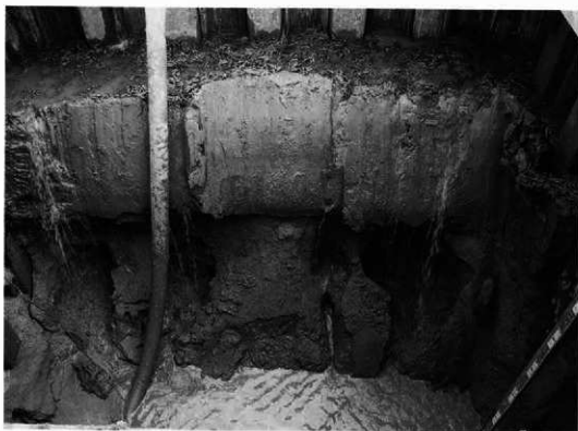
トレンチ断面状況
