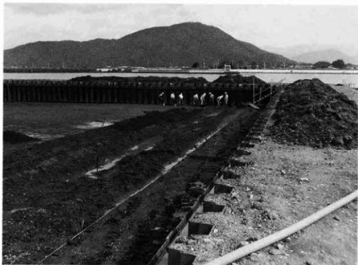
上層部掘削作業風景
