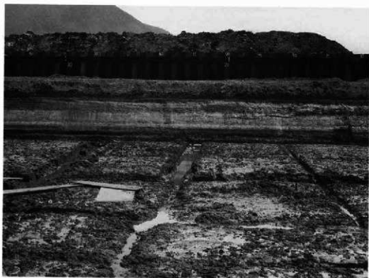
下層部完了近景
