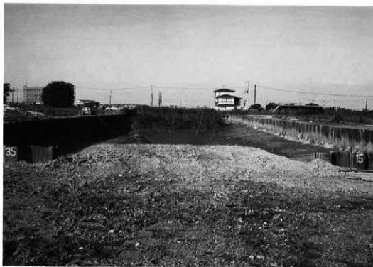
調査前近景（南西より）
