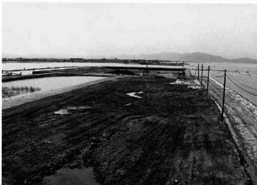
調査区遠景 (北より)
