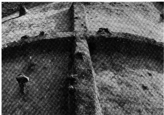
2. 同 調査後の状況(東から)
