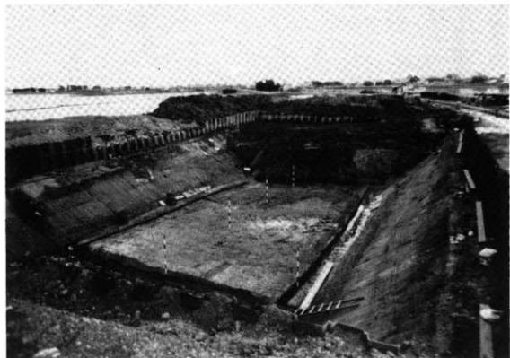
第1トレンチ全景 (南より)
