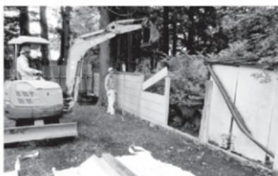
第1435図 復旧工事箇所周辺の支障構造物撤去状況
