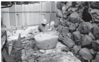
第1451図 新補石材加工状況(1)
