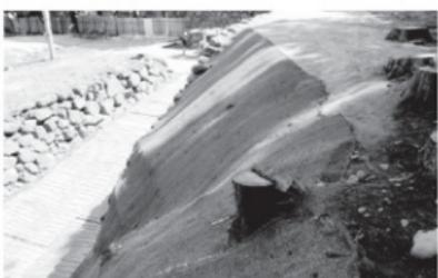
第1456図 法面補強工施工後状況
