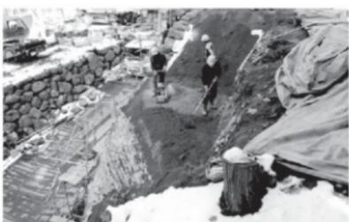
第1454図 斜面部分のたたき仕上げ作業状況
