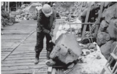
第1452図 新補石材加工状況(2)
