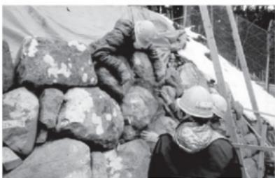
第1444図 現地における崩落石材の位置推定作業状況
