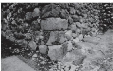
第1458図 FG面隅角部積み直し状況(北西から)
