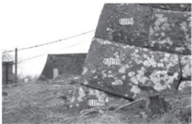
第988図 G面角石GH-9・10のセットバック(西から)
