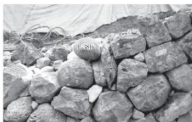
第862図 E北面谷落し積み部分(西から)
