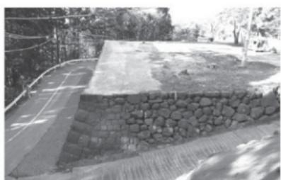
第449図 C面天端の盛土施工状況(南から)
