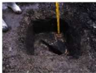
写真93 3Tピット断面 (S→)
