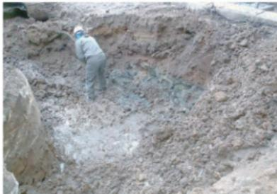
で南北に走っておりこれをまたぐように設置されていた。柱基礎撤去は地表下 80cm まで達し、その下に瓦屑を確認したが、すべてが近現代のものであった。瓦屑下には黄褐色粘質土、灰褐色粘質土が堆積するが管路溝敷設のための埋土である。管路溝下は玉石があるが、地表下 130cm まで搅乱であることを確認した。
