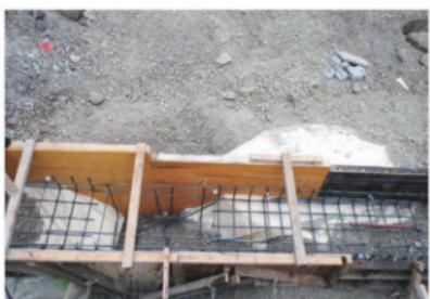
9月24日 側溝の設計変更により磐石を保護し、埋設保存とした。
