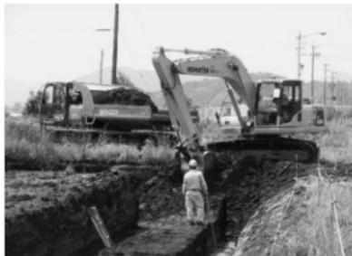
写真1 重機による表土除去作業
