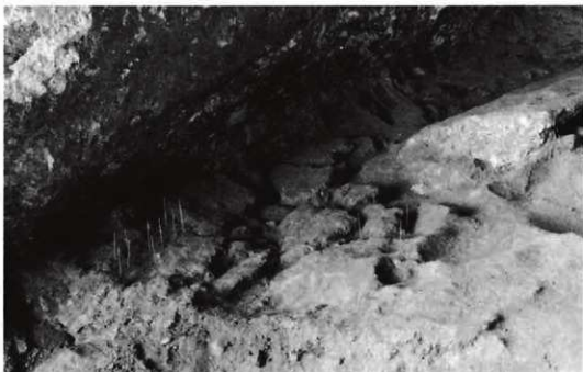
D-5・6グリッドの落石の状況
