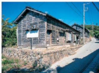
図1-4 石垣を用いて造成された敷地の上に建つ鉱山住宅
