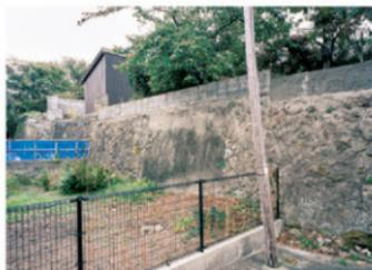
図1-3 斜面の敷地造成による高低差に造られた多くの石垣
