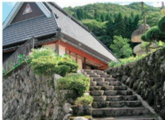
図7-4 石臼の未製品を用いた階段
