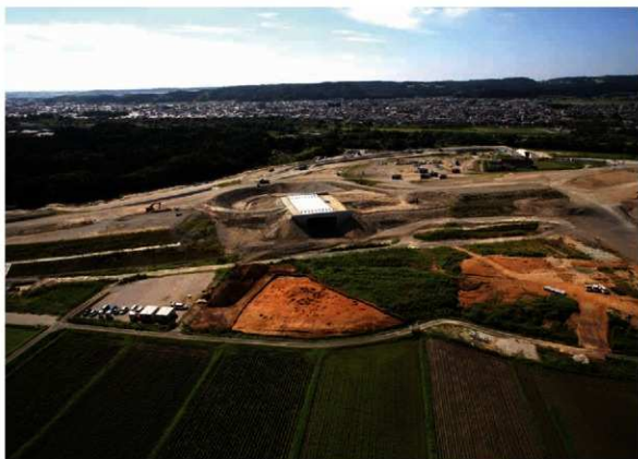
写真8 調査区全景（北上空から）
