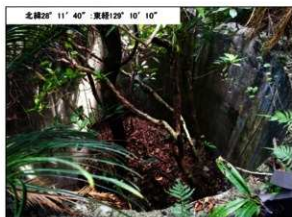
第155圖 不明施設跡 (コンクリート製)
