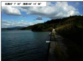
北緯28° 7' 22"・東経129° 14' 56" 第238図 大島防備隊護岸跡
