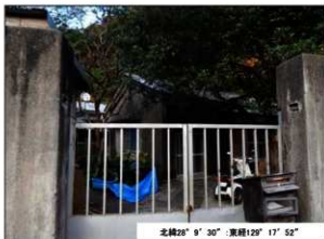
第67図 手安弾薬本庫 監視舎跡
