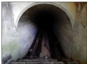
第202図 海軍艦船給水ダム跡 (施設内部)
