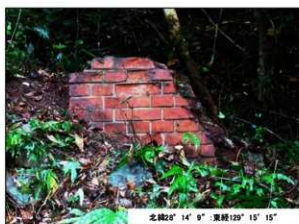
第82図 赤煉瓦構造物(濾水池)跡
