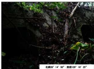
第77図 古志砲台砲座弾薬置場跡
