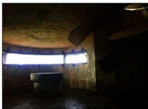
第128図 掩蓋式観測所跡 (内部)
