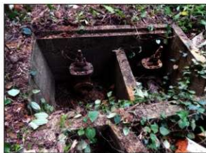
第203図 海軍艦船給水ダム跡 (排水・送水バルブ)
