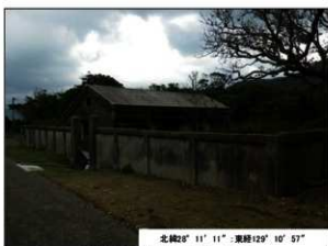
第158図 監守衛舎跡 近景
