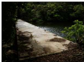
第198図 海軍艦船給水ダム跡 (堤体)
