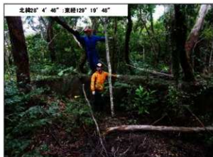
第321図 砲台跡 (コンクリート製)
