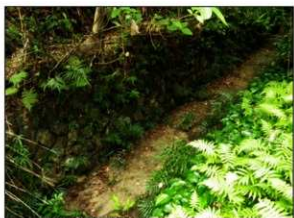
第204図 海軍艦船給水ダム跡 (排水路)
