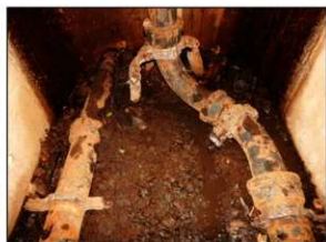
第200図 海軍艦船給水ダム跡 (排水・取水施設)
