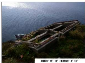
第137図 貯水槽跡(明治29年灯台施設)
