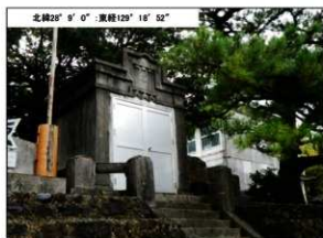
第355図 古仁屋小学校旧奉安殿
