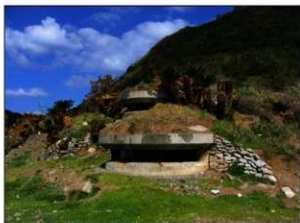
第126図 掩蓋式観測所跡 近景
