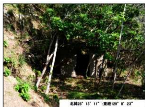
第139図 不明施設跡(鉄筋コンクリート建造物)
