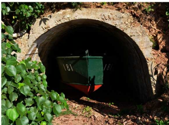
第18震洋艇壕跡（Ⅳ期）
