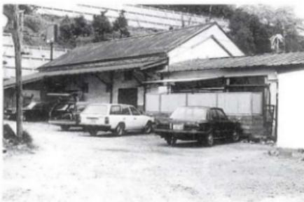
建ち、他の三方の柱脚は切り取ってコンクリート基礎をまわし、十五寸×十二寸の木材の土台を挿入しているなどである。柱の太さは十五・四角で、その柱の間隔は約七十七寸(二・五尺)である。窓換気孔は各戸前上部に、また後補かと考えられる換気孔が二戸前中間上部に設けられている。
