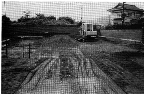
I 区埋め戻し作業風景（南東より）
