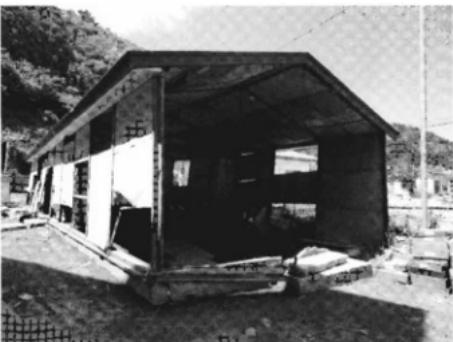
写真3 津波で被災したプレハブ収蔵庫
