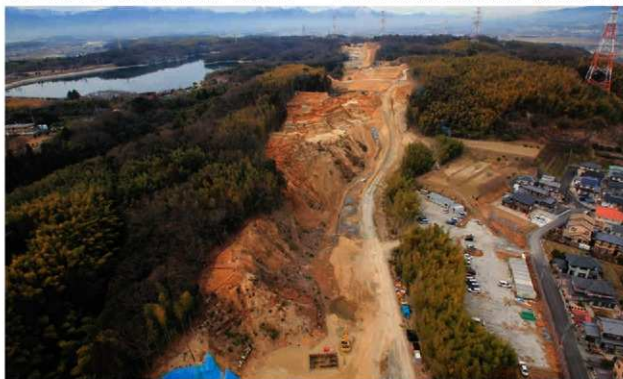
写真17 調査区遠景(東上空から)
