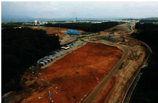
写真39 調査区全景（南西から）
