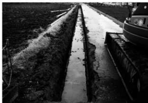
湯田西浦遺跡 調査区全景(東から)
