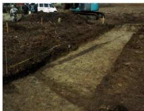
写真112 T2（南東から）
