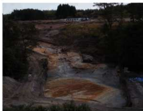
写真64 ②区完掘全景(北から)
