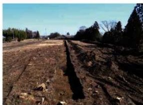
写真121 T2全景（西から）
