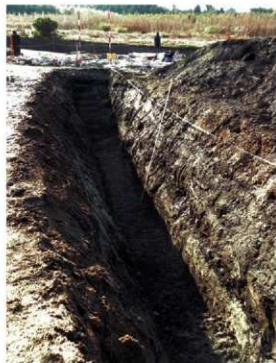
写真 101 調査区（東から）
