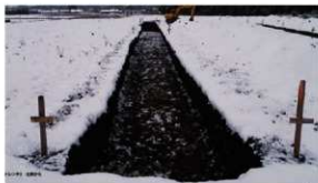
写真96 T3（北西から）
