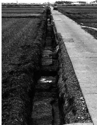
第2次(支線)調査区全景(南から)
