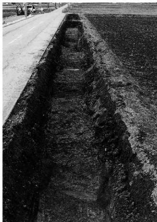
工事立会調査区全景(東から)
