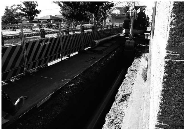
工事立会状況（西から）
