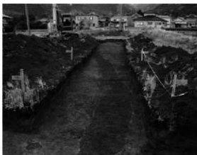
写真29 トレンチ17 (東から)
