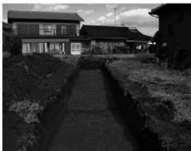
写真28 トレンチ7 (南から)
