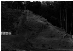
写真1 斜面部トレンチ全景(北東から)
