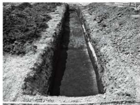
図版 4 3区完掘状況(南東から)
