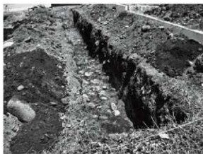
図版6 1区完掘状況 (南東から)
