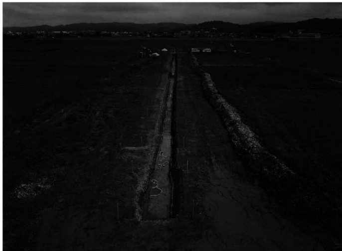
A区 全景 空中写真(西から)
