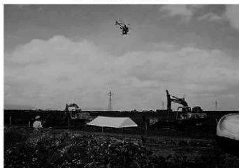
A区 空中写真撮影（南から）
