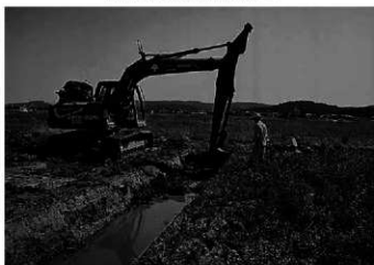
B区 表土掘削作業（西から）
