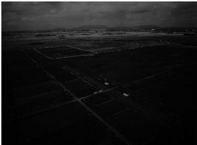
A区 全景 空中写真(東から)
