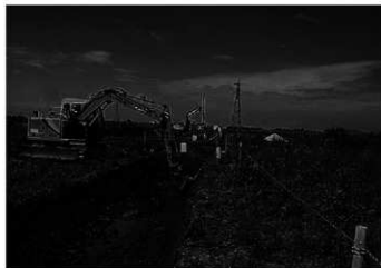
A区 表土掘削作業（東から）
