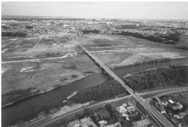
調査前風景（南側上空から）
