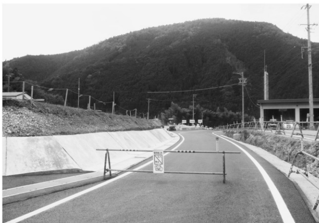
工事中の状況
