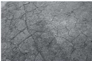
SX301 埴輪列掘形検出状況 (南から)
