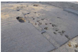
13 SD01・02 完掘状況(南西から)
