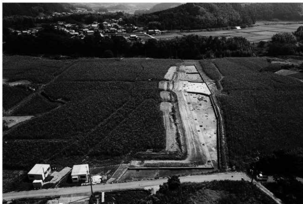
調査区全景(南西から)
