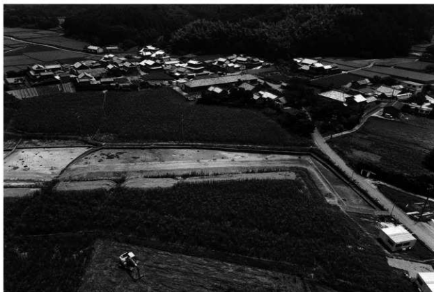
A地区・B地区付近(北西から)
