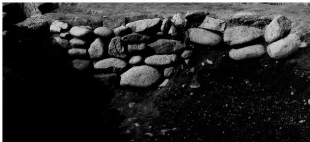
SK228北壁(南から)
