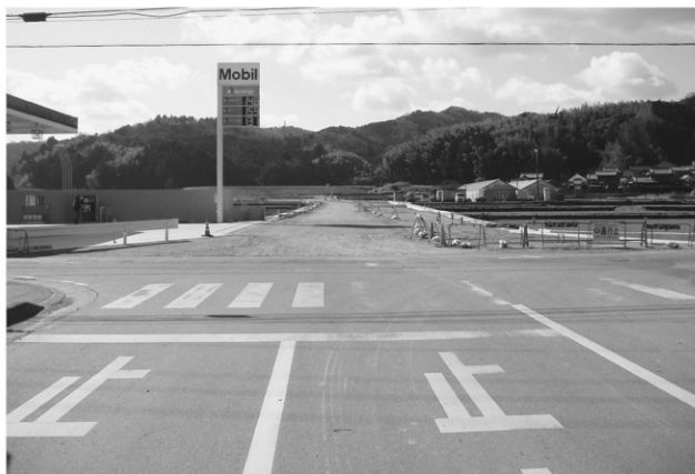
調査区工事後状況（北から）
