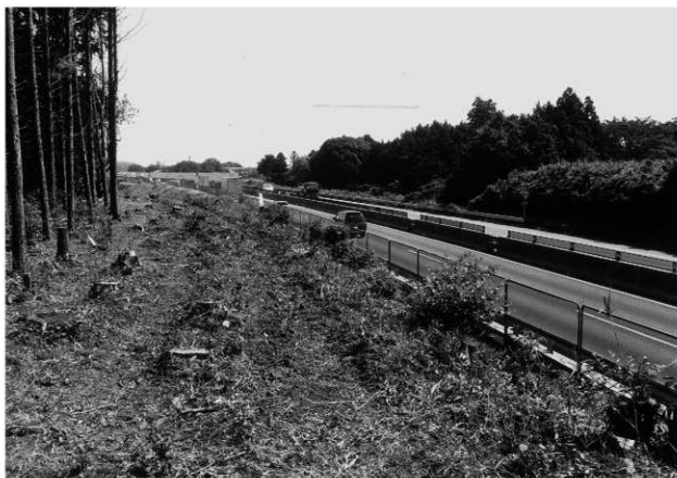
調査前風景（南東から）
