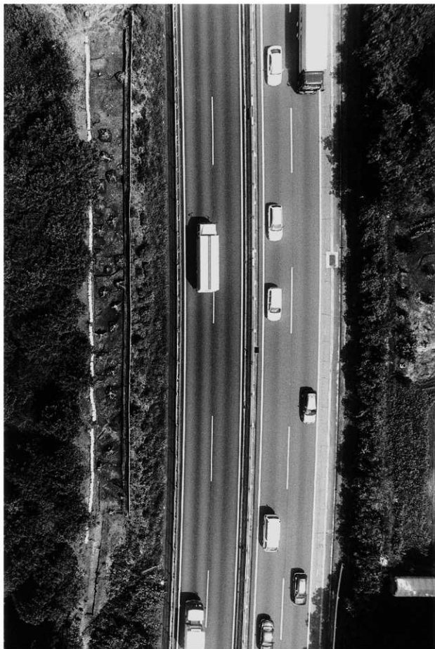
調査区全景（直上から 写真上が北東）
