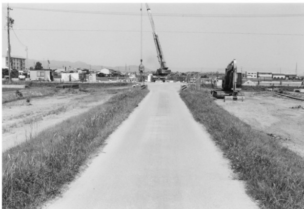
調査前全景（東から）
